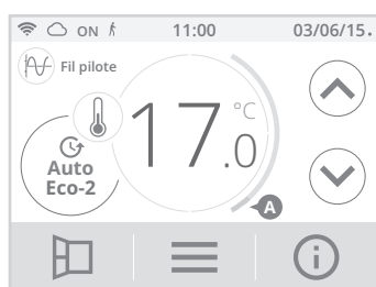
Fil pilote = Éco - 2 Confort - 2°C
